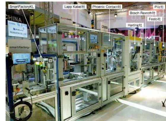
スマート工場の生産ライン - 7社の設備を接続 (日経ものづくり / 2015年5月)
