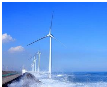
図52-27 ウィンド・パワー・かみす洋上風力発電所(茨城県2000KW x 7基) ②
