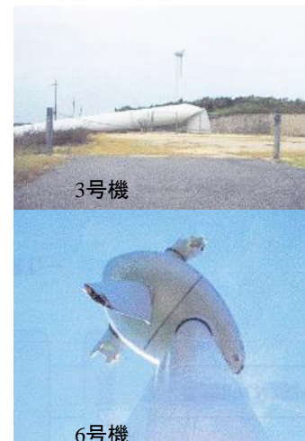
図52-10 強風による折損事故 (狩俣風力-沖縄電力/2003年9月台風16号)
