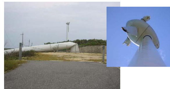
機械の破壊事故(上から一尼崎列車脱線、 もんじゅ温度計折損、狩俣風力発電倒壊)
