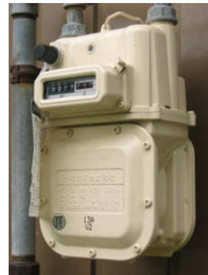
図19-2 マイコン内蔵都市ガスメーター
