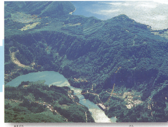
第二新潟発電所(新潟県) 総出力46万kW (一般家庭約15.3万軒分に相当中)
